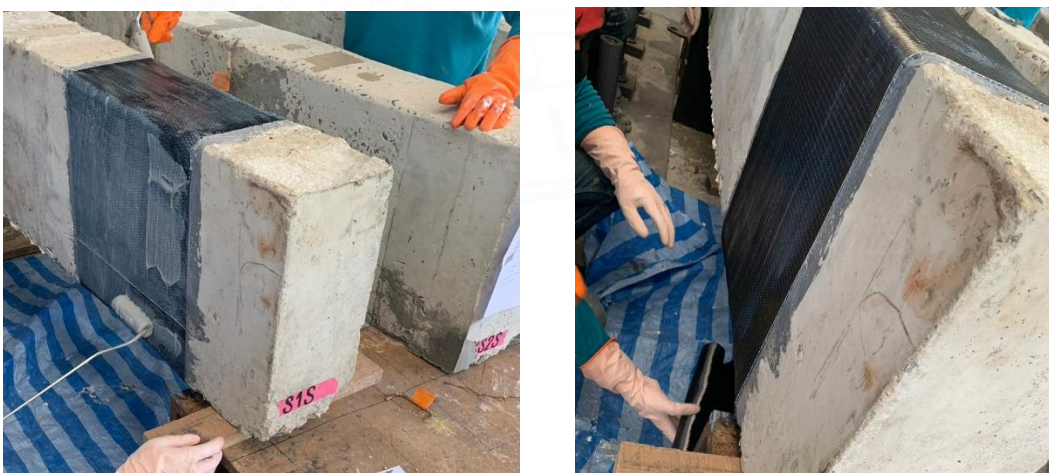
ภาพที่ 3.25 การติดตั้งแผ่นคาร์บอนไฟเบอร์ชั้นที่ 2
