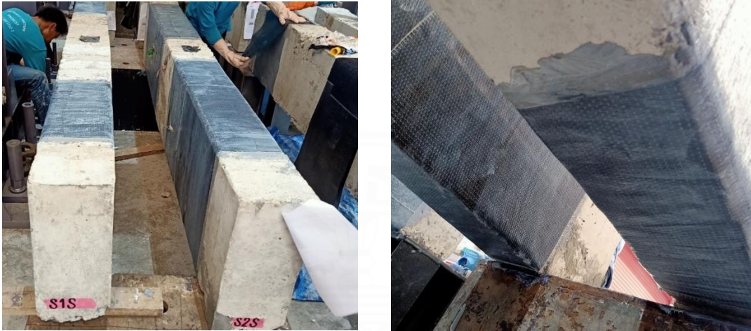
ภาพที่ 3.26 การติดตั้งแผ่นคาร์บอนไฟเบอร์ที่เสร็จเรียบร้อยแล้ว
