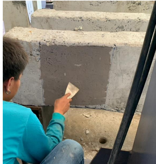
ภาพที่ 3.20 เกร้าที่ผิวคอนกรีตเพื่อป้องกันการเกิดฟองอากาศ
