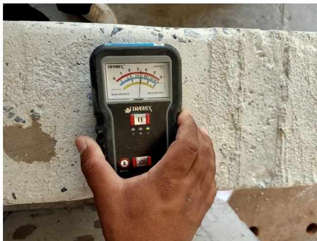
ภาพที่ 3.21 เครื่อง concrete moisture meter
