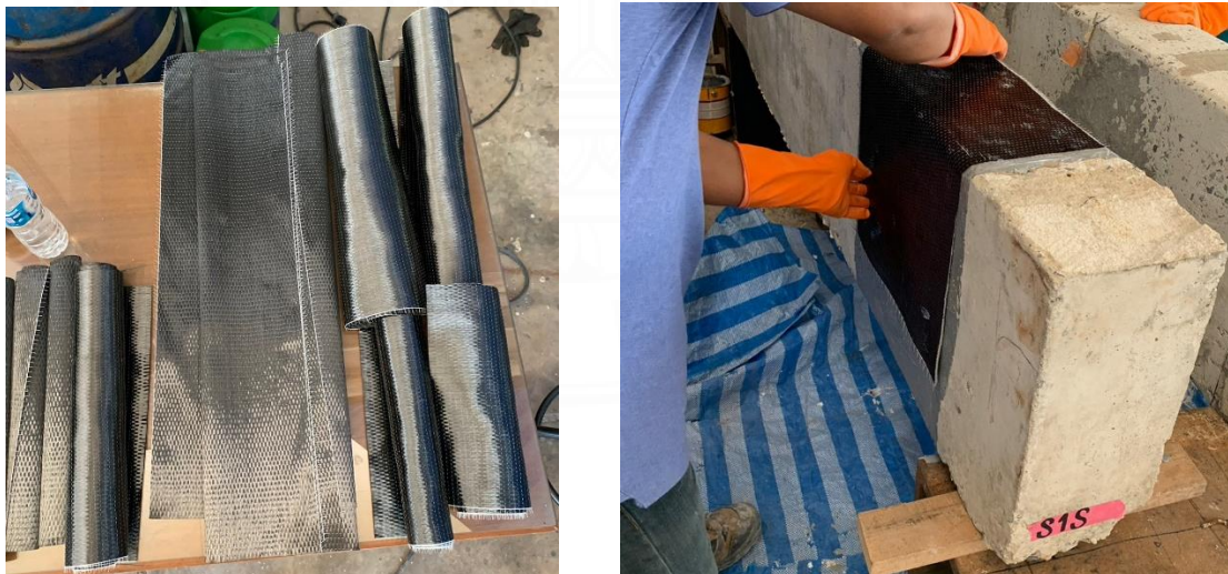
ภาพที่ 3.23 ติดตั้งแผ่นคาร์บอนไฟเบอร์
