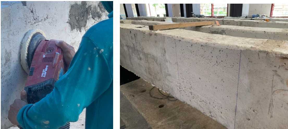
ภาพที่ 3.19 การเตรียมผิวคอนกรีตให้เรียบ
