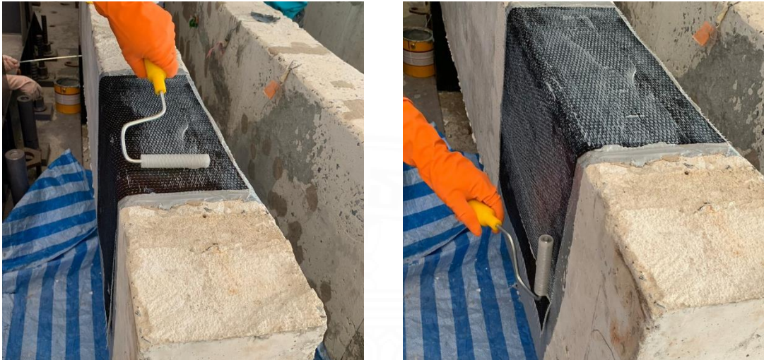
ภาพที่ 3.24 ใช้ลูกกลิ้งรีดไล่ฟองอากาศ
