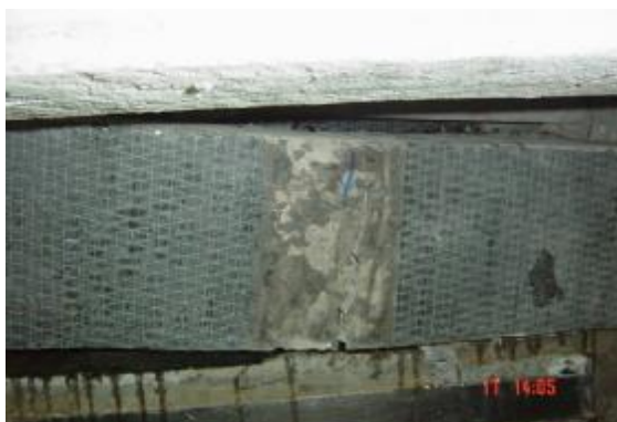
รูปที่ 4 แสดงลักษณะการเกิดรอยร้าวของคาน A2
