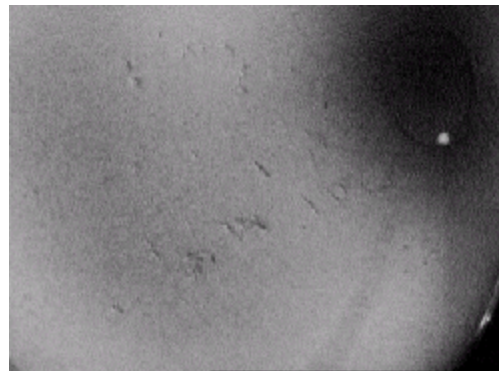
รูปที่ 8 ภาพที่เก็บได้จากท่อกลมปล่องไฟ ขนาด 10 นิ้ว
