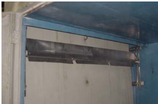
รูปที่ 3.1.1 การติดตั้งไปบั้งคับทิศทางการไหลของอากาศร้อนในตู้อบ
