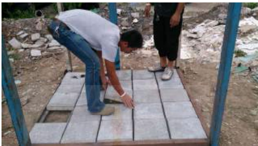
ภาพที่ 4.24 การวางแผ่นคอนกรีตบดล็อกปูพื้นโรงอบแห้งจำลอง
