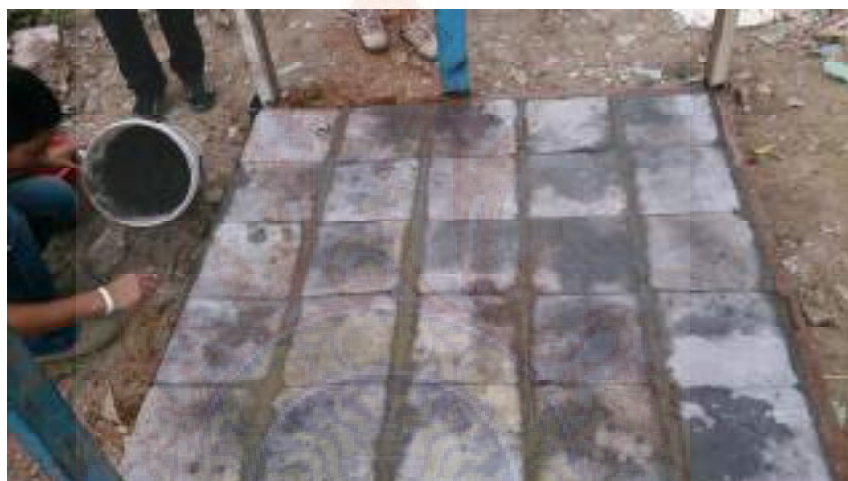
ภาพที่ 4.25 ขาแนวแผ่นคอนกรีตบดล็อกปูพื้นโรงอบแห้งจำลอง
