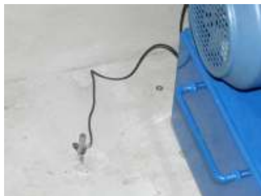
(ข) การติดตั้งสายดิน
