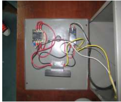
(ข) ตู้ควบคุม
