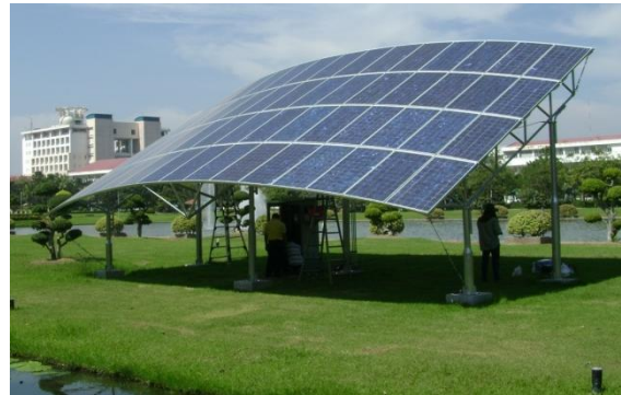
รูปที่ 16 แผงเซลล์แสงอาทิตย์ที่ใช้ในการติดตั้งเครื่องมือวัด
