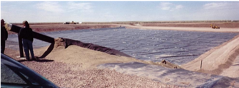
ภาพที่ 2.6 การเตรียมสถานที่ฝังกลบแบบปลอดภัย (Secure landfill)
