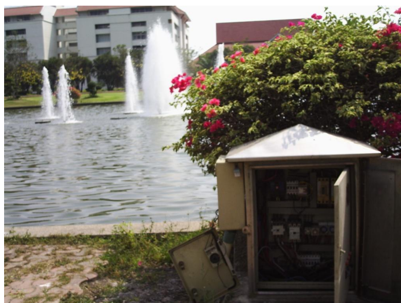
รูปที่ 3.1 จุดที่ต่อแรงดันไฟฟ้าของระบบแรงต่ำ [3]
