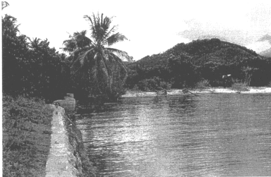
ภาพที่ 4.18 พื้นที่ที่ถูกกีดเซาะบริเวณปากคลองลิปะใหญ่ติดกับพื้นที่ตำรวน้ำ
