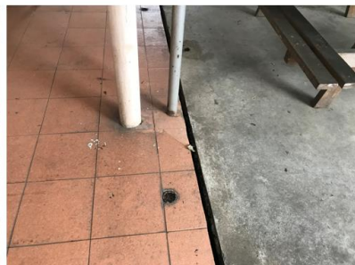
M รอยต่อวัสดุบริเวณทางเชื่อมอาคาร
