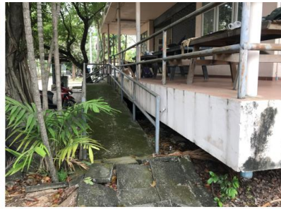
K ทางลาดหน้าอาคาร
