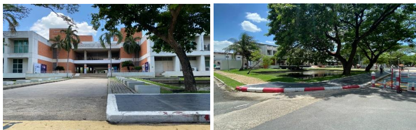
ภาพที่ 4 แสดงความสูงของทางสัญจรที่สูงจากผิวจราจร 0.14 เมตร ไม่ปรากฏทางลาดตัดคันหินและทางลาดที่เชื่อมต่อเข้าสู่ทางเดินเข้าอาคาร (ซ้าย) (บันทึกภาพถ่ายเดือนกรกฎาคม พ.ศ. 2565)
