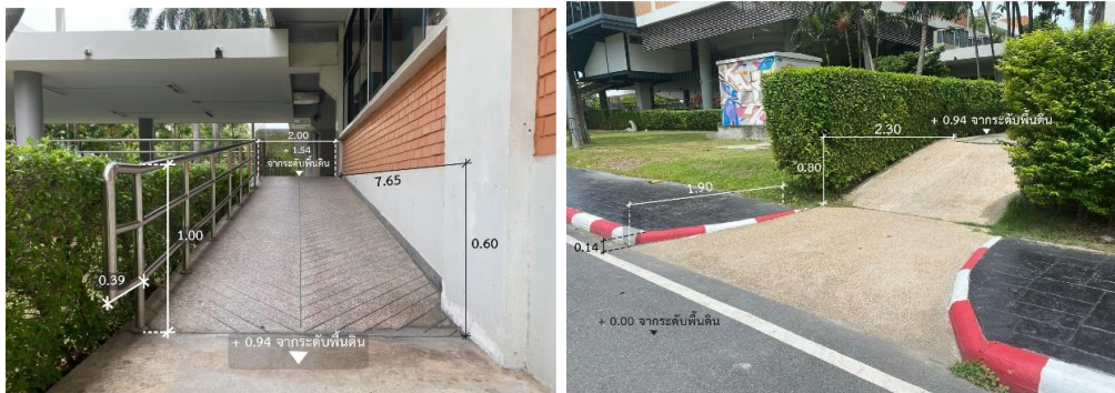
ภาพที่ 17 แสดงทางลาดเข้าออกอาคารบริเวณอาคารสำนักงานอธิการบดี (บันทึกภาพถ่ายเดือนกรกฎาคม พ.ศ. 2565)
