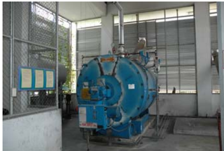
ภาพที่ 4.3 หม้อไอน้ำของโรงพยาบาลนครพิงค์
