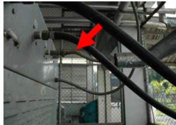
ภาพที่ 4.9 การซ่อมแซมรอยรั่วของหม้อไอน้ำ จุดที่ 2
