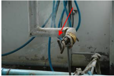
ภาพที่ 4.5 รอยรั่วของท่อไอน้ำ
