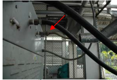
ภาพที่ 4.5 รอยรั่วของท่อไอน้ำ
