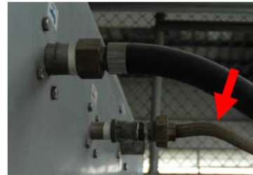
ภาพที่ 4.9 การซ่อมแซมรอยรั่วของหม้อไอน้ำ จุดที่ 2
