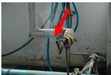
ภาพที่ 4.8 การซ่อมแซมรอยรั่วของหม้อไอน้ำ จุดที่ 1
