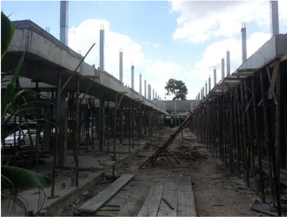
ภาพที่ 4.3 โครงการบ้านมั่นคงขณะกำลังก่อสร้างในเฟสที่ 2
