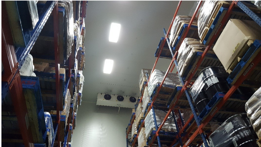
ภาพที่ 4.2 การเปิดเครื่องปรับอากาศที่อุณหภูมิ 25 องศาเซลเซียสภายในศูนย์กระจายสินค้าผลิตภัณฑ์และวัตถุดิบอุตสาหกรรม และเทคโนโลยี จ. พระนครศรีอยุธยา
