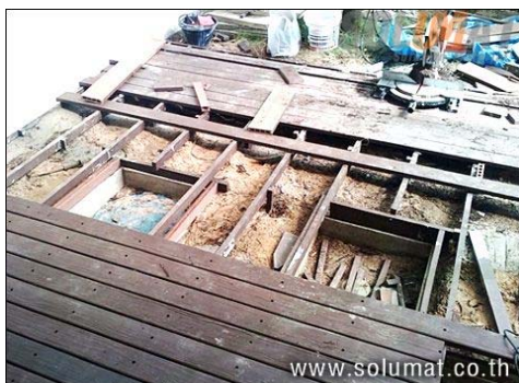
ภาพที่ 19 การติดตั้งผลิตภัณฑ์ไม้ประกอบพลาสติกชนิดกลวง
