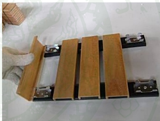
ภาพที่ 20 การติดตั้งผลิตภัณฑ์ไม้ประกอบพลาสติกชนิดรูปตัว C โดยใช้ระบบคลิปล็อก
