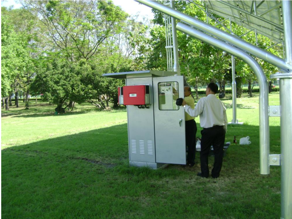
รูปที่ 4.3 การทดสอบระบบหลังการติดตั้งระบบไฟฟ้าร่วมกับผู้เชี่ยวชาญของบริษัทฯ
