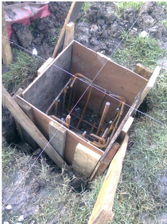
รูปที่ 3.3 การเตรียมท่ฐานรากรองรับโครงสร้างแผงเซลล์แสงอาทิตย์
