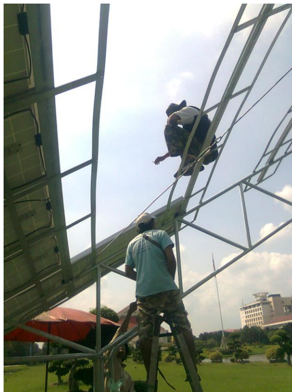
รูปที่ 3.6 การติดตั้งแผงเซลล์แสงอาทิตย์
