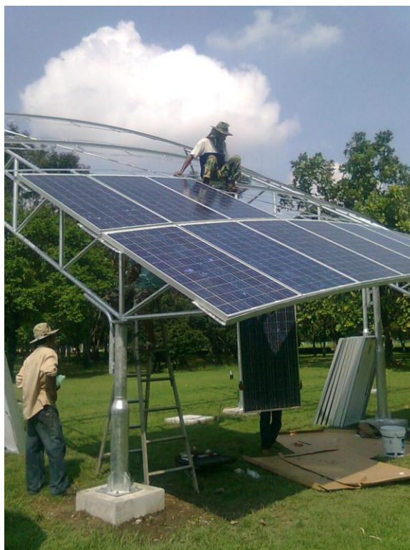
รูปที่ 3.7 ด้านหน้าของการติดตั้งแผงเซลล์แสงอาทิตย์
