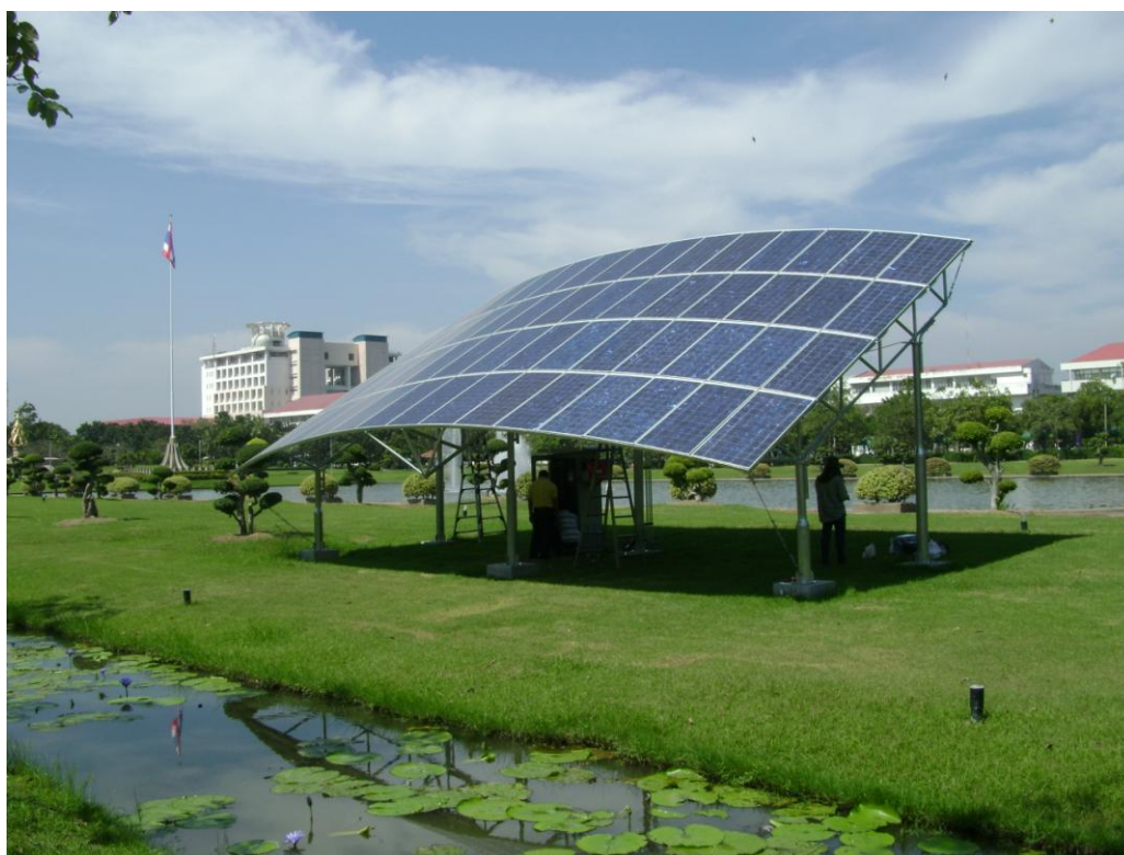
รูปที่ 3.9 การติดตั้งแผงเซลล์แสงอาทิตย์แล้วเสร็จ ขนาดรวมทั้งหมด 10 kW p
