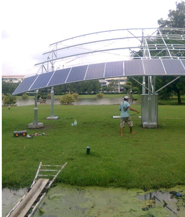
รูปที่ 3.5 การติดตั้งแผงเซลล์แสงอาทิตย์ บน โครงสร้างรองรับแผงเซลล์แสงอาทิตย์
