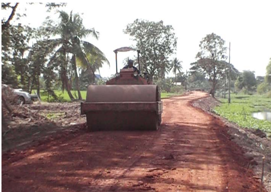
รูปที่ 45 ลักษณะการบดอัดชั้นทางต่างๆ
