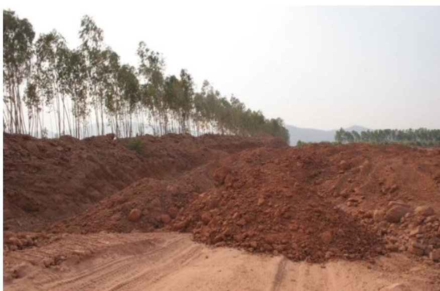
รูปที่ 29 ลักษณะของการนำดินมากองในพื้นที่ที่เหมาะสม เพื่อใช้ประโยชน์ต่อไป
