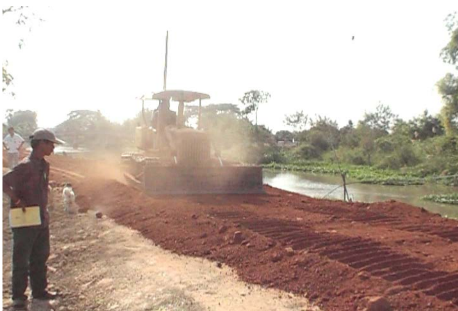
รูปที่ 42 การเกลี่ยปรับวัสดุดินลูกรังหลังจากที่เทลงบริเวณผิวทาง
