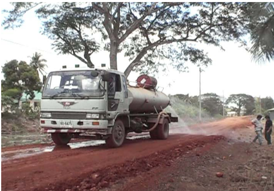
รูปที่ 44 การพรมน้ำลงบนวัสดุดินลูกรัง เพื่อรอการบดอัดต่อไป
