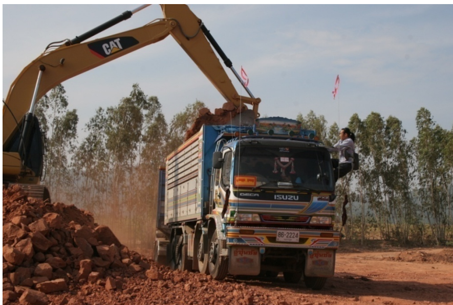
รูปที่ 33 ลักษณะการตักปริมาณวัสดุดินลูกรัง
