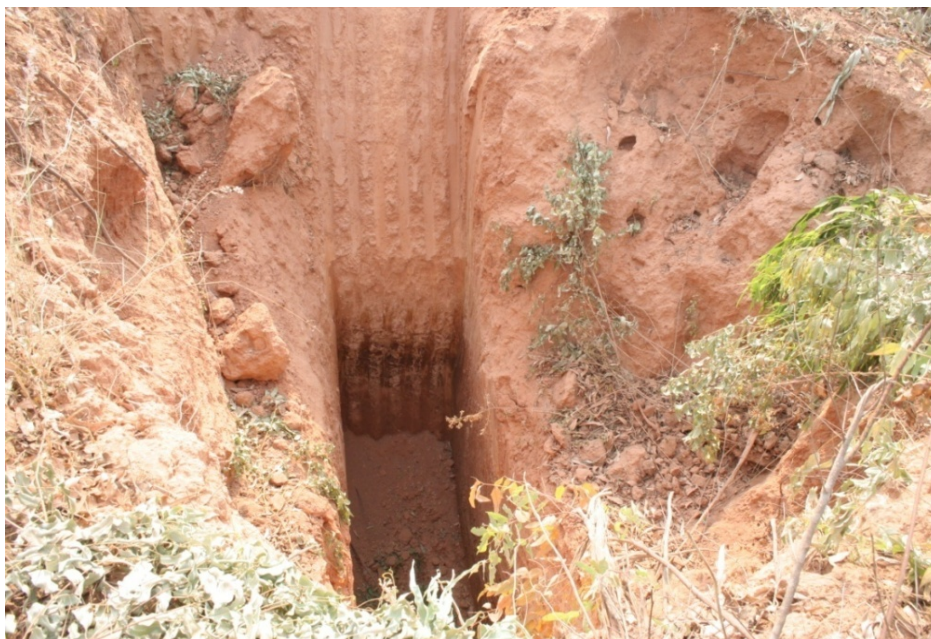
รูปที่ 14 การขุดเจาะหลุม โดยมีความกว้างประมาณ 2 - 4 เมตร
