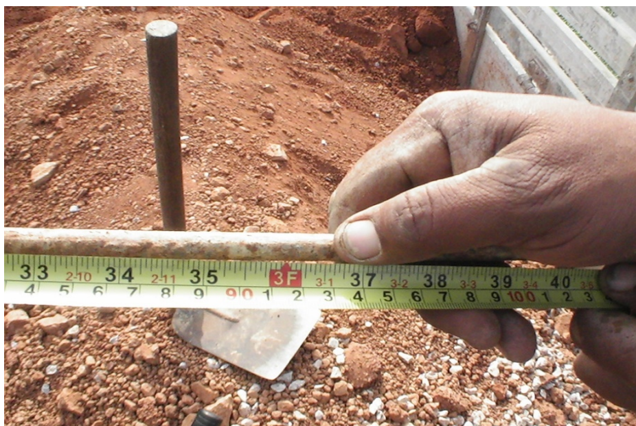
รูปที่ 39 การวัดระยะปริมาณวัสดุที่ได้บรรทุกมายังหน้างาน
