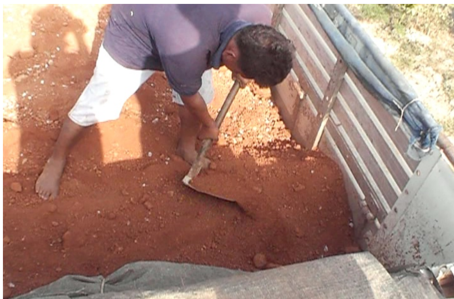
รูปที่ 36 การเกลี่ยวัสดุดินลูกรัง
