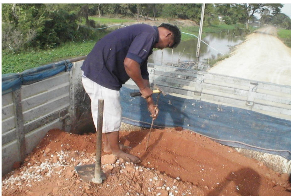
รูปที่ 38 การตอกเหล็กส่วนท้ายกระบะ ซึ่งเป็นส่วนสุดท้ายในการตรวจสอบปริมาณวัสดุ
