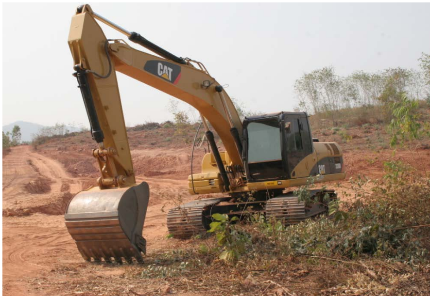
รูปที่ 12 รถแบคโฮที่ใช้ในการขุดสำรวจชั้นดินลูกรัง และเปิดบ่อดินลูกรัง
