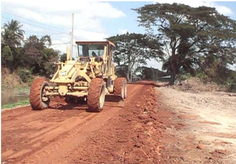
รูปที่ 43 ลักษณะการปรับวัสดุดินลูกรังให้มีระดับตามที่ออกแบบไว้
