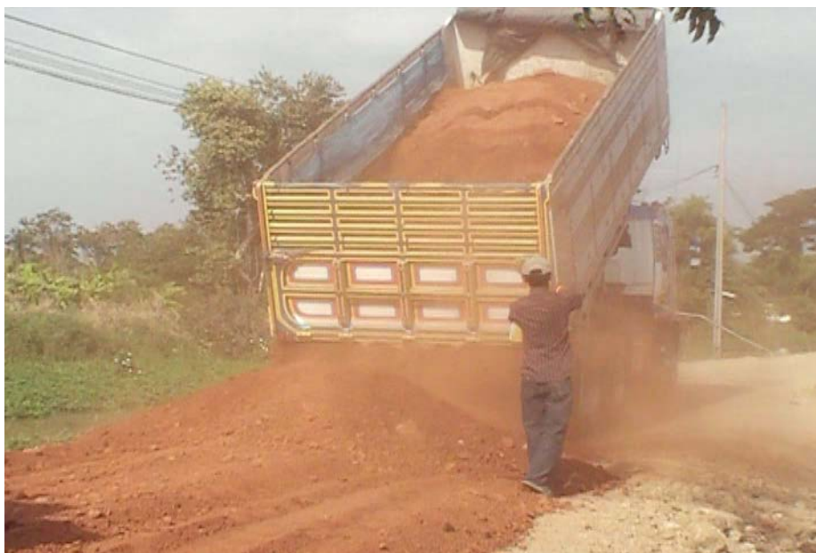
รูปที่ 41 การขนถ่ายวัสดุให้กับทางหน้างาน
