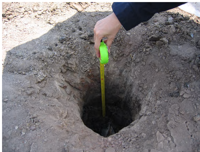
ภาพผนวกที่ ก3 จุดที่ทำการศึกษาดินกลบทับชั้นสุดท้ายพื้นที่ฝังกลบมูลฝอย
