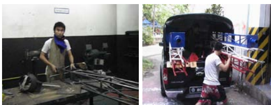
รูปที่ 24 กังหันลม ขนาด 200 W 124V.DC ความสูงเสา กังหัน 9 เมตร จัดทำและเตรียมขนย้ายไปยัง กรมทหาร พรานที่ 36 เพื่อนำไปติดตั้งที่ ฐานปฏิบัติการทหารพราน ฐาน BP 16 คอยผาดัง แม่สะเรียง
