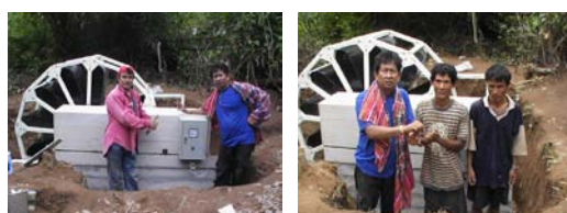
รูปที่ 37 วงล้อน้ำที่สำเร็จเรียบร้อย และมอบให้ผู้ช่วย ผู้ใหญ่บ้านห้วยโป่ง และสมาชิก อบต.เสาคหิน ประสาน อบต.เสาคหินเพื่อดำเนินการเชื่อมต่อสายส่ง เข้าหมู่บ้านใช้ งานกับระบบแสงสว่างต่อไปต่อไป
