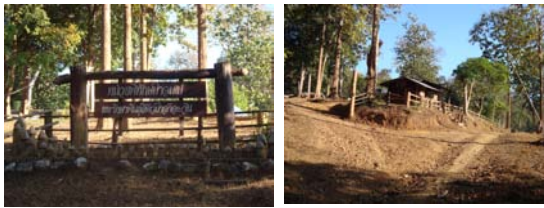
รูปที่ 5 สภาพ หน่วยพิทักษ์ป่าอมเป ตำบลเสาหิน มีกำลังเจ้าหน้าที่ 10 นาย ใช้ไฟฟ้าจากแผงโซลาร์เซลล์ แต่ไม่เพียงพอ
