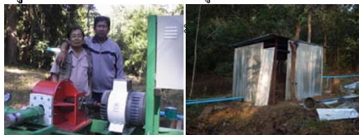
รูปที่ 18 นักวิจัย ติดตั้งกังหันน้ำ และทำโรงเก็บ
