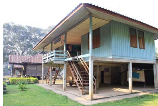
รูปที่ 3 สถานีตำรวจภูธรเสาหิน ที่เป็นสถานีตำรวจที่อยู่ใกล้ชายแดนพม่าที่ใช้ไฟฟ้าจากแผงโซลาร์เซลล์จะเห็นสถานีตำรวจหลังเก่าตั้งอยู่ถัดไป
