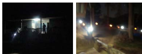
รูปที่ 20 ทดลองใช้พลังงานไฟฟ้า กับระบบส่องสว่างภายใน หน่วยพิทักษ์ป่าอมเป
