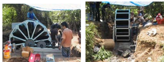
รูปที่ 34 นักวิจัย และผู้ช่วยนักวิจัยและชาวบ้าน ประกอบ Bucket เข้ากับโครงวงล้อน้ำ และทาสี
