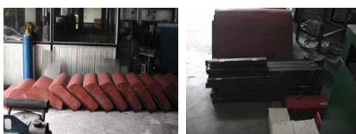
รูปที่ 30 วงล้อน้ำถูกถอดเป็นชิ้น เพื่อขนย้ายนำไปติดตั้งใน พื้นที่บ้านห้วยโป่ง
