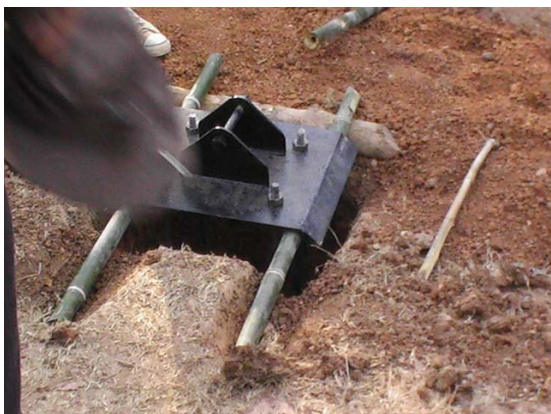
รูปที่ 129 ขุดหลุมติดตั้งฐานกัณฑ์หลม
