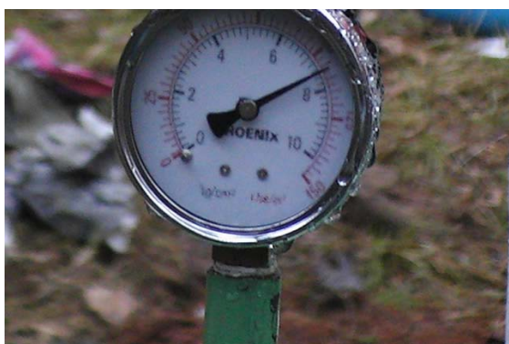
รูปที่ 113 การทดสอบแรงดันภายในท่อส่งน้ำเข้า กังหันผลิตไฟฟ้า
