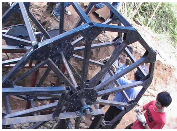
รูปที่ 215 ประกอบโครงขึ้นส่วนเป็นรูปวงล้อน้ำ
