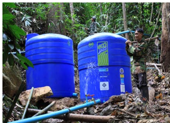
รูปที่ 96 ติดตั้งท่อส่งน้ำจากถังพักน้ำ วาล์ว ปิดเปิด และวาล์วไล่อากาศภายในท่อ
