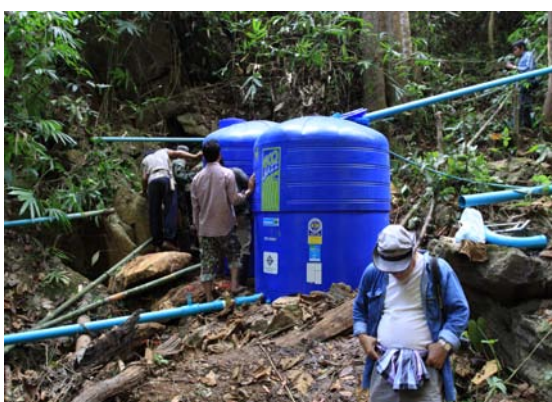
รูปที่ 95 ดำเนินการติดตั้งตำแหน่งถังพักน้ำ ไว้ด้านข้างริมห้วยเพื่อป้องกันน้ำป่า
