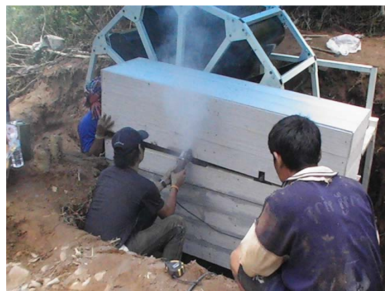
รูปที่ 226 ปิดฝาครอบและปรับแต่งฝาครอบชุด เฟืองโซ่และสายพาน
