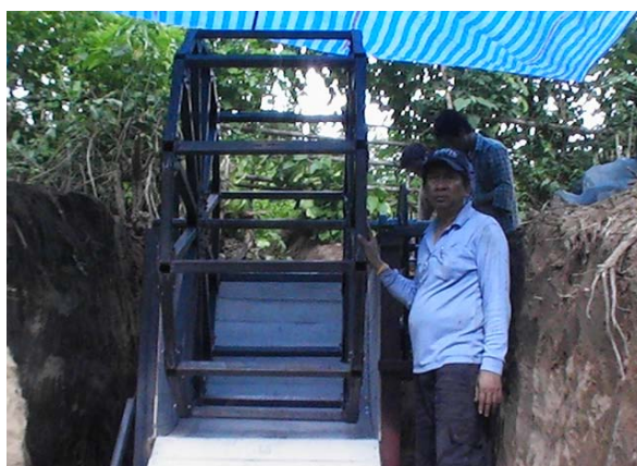
รูปที่ 218 ประกอบแผ่นไม้เขอรัดติดกับโครงฐานวงล้อน้ำ
