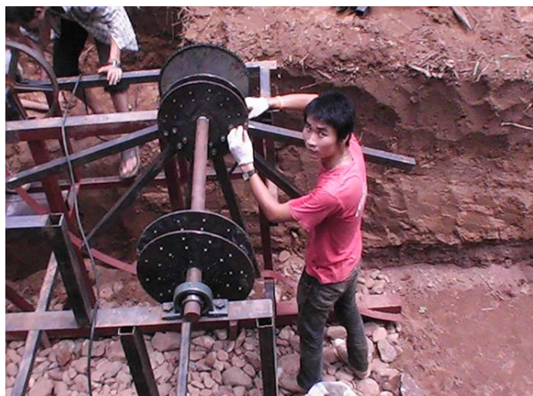
รูปที่ 213 ติดตั้งเพลลาและคัมยิด โครงวงล้อน้ำ
