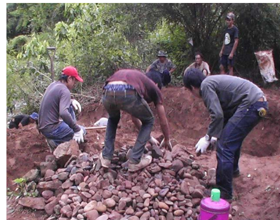
รูปที่ 206 กองหินแม่น้ำที่ชาวบ้านจัดเตรียมไว้สำหรับรองฐานวงลื่อน้ำ
