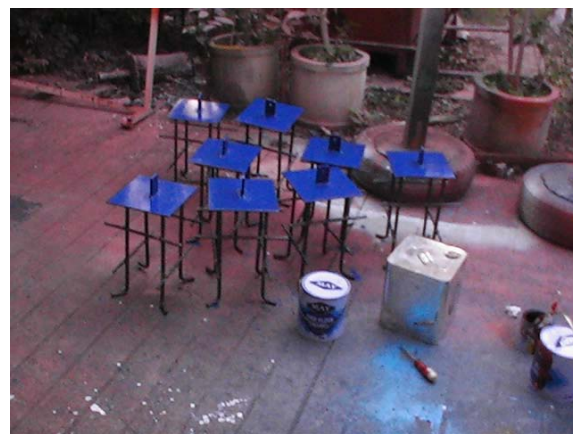
รูปที่ 142 จัดเตรียมทาสีฐานยึดสลิงของเสาเข็ม
