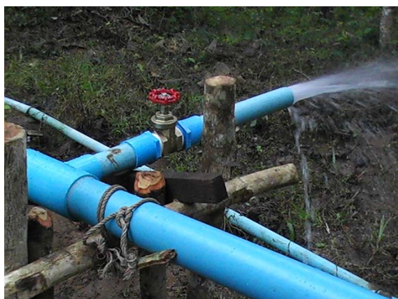
รูปที่ 111 ทดลองเปิดวาล์ว by pass เพื่อไล่อากาศ
