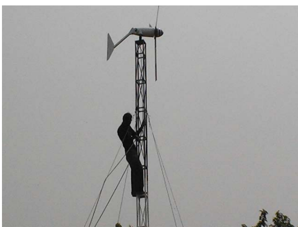
รูปที่ 167 เจ้าหน้าที่ทหารพราน BP 16 ปีนเสากังหัน ลมเพื่อตรวจสอบจุดยึดสลัก
