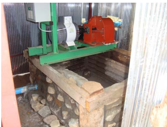
รูปที่ 119 ติดตั้งโรงกังหันน้ำ โดยใช้พลังงานไฟฟ้าจากพลังงานน้ำ
