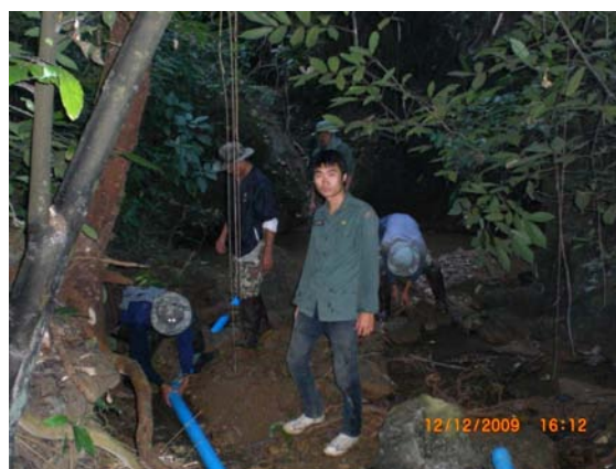
รูปที่ 100 ผู้ช่วยนักวิจัย ติดตั้งท่อส่งน้ำจาก ถ้ำพักน้ำ เปลี่ยนทิศทางท่อด้วยข้องอ 45
