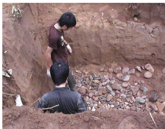
รูปที่ 210 เปลี่ยนหินปรับพื้นให้ได้ระดับเพื่อวางประกอบฐานวงล้อน้ำ
