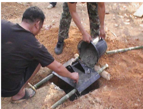
รูปที่ 131 เทปูนยึดฐานเสา กัณฑ์หลม
