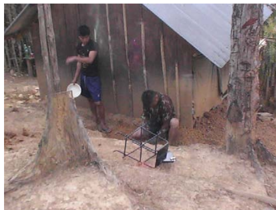
รูปที่ 130 ขุดหลุมติดตั้งฐานยึดสลิงกับเสา กัณฑ์หลม
