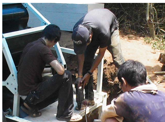
รูปที่ 222 ติดตั้งไม้เชอร์ราเพื่อรองรับ Water intake
