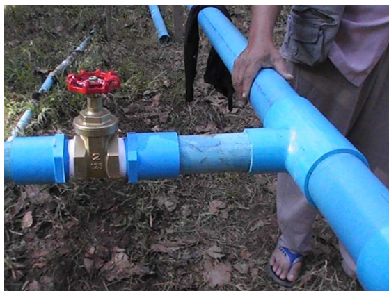
รูปที่ 109 ติดตั้งระบบท่อ by pass และวาล์ว
