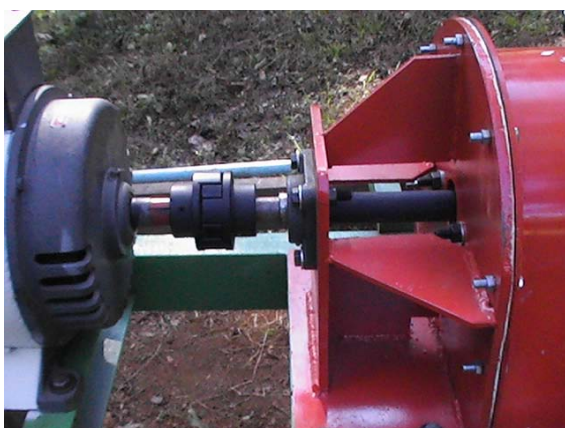
รูปที่ 107 ตรวจสอบเพลาส่งกำลังไปยังเครื่องกำเนิดไฟฟ้า
