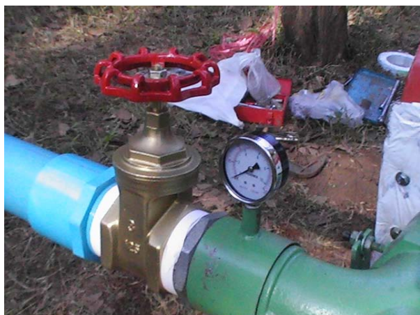
รูปที่ 83 ติดตั้งเกจวัดความดันน้ำภายในท่อ
