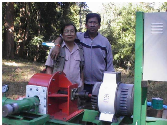
รูปที่ 110 หลังจากเดินระบบท่อ และยึดฐาน เรียบร้อย
