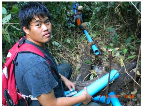
รูปที่ 98 ผู้ช่วยนักวิจัย ติดตั้งท่อส่งน้ำจากถ้ำ พักน้ำ ผ่าน โขดหินที่ลาดเอียงและป่าริมห้วย
