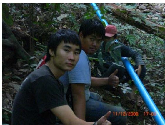
รูปที่ 99 ผู้ช่วยนักวิจัย ติดตั้งท่อส่งน้ำจากถ้ำ พักน้ำ ผ่านผาหินที่ลาดชัน
