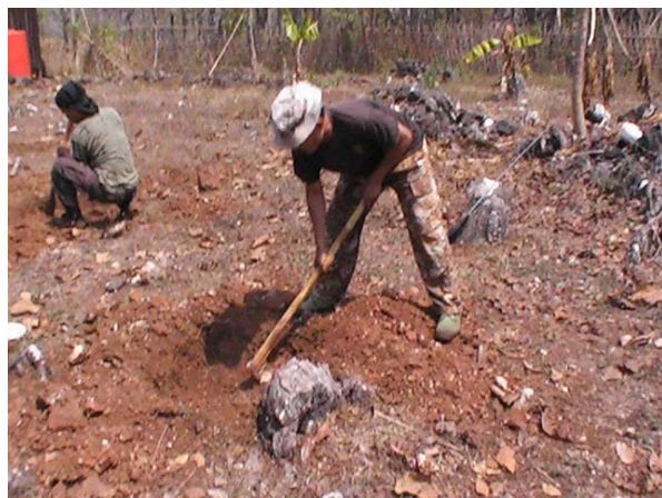
รูปที่ 152 เจ้าหน้าที่หน่วยทหารพราน BP 16 ช่วยกันขุดหลุมทำฐานยึดเสาทั้งหันลม
