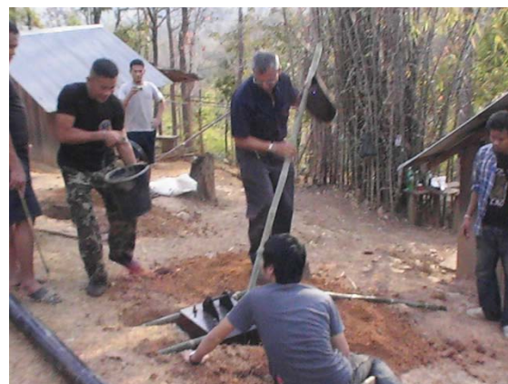
รูปที่ 132 นักวิจัยปรับระดับฐานกัณฑ์หลมหลังจาก เทปูนยึดฐาน
