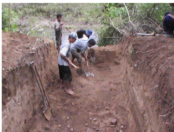
รูปที่ 205 ทีมชาวบ้านทำการขุดหลุมตามขนาดที่กำหนด
