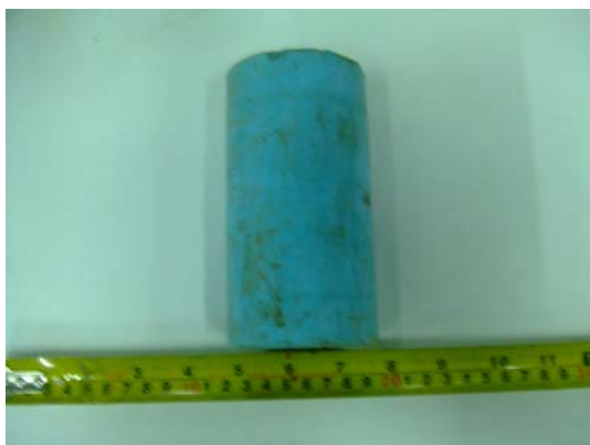
รูปที่ 44 สภาพท่อน้ำเก่า
