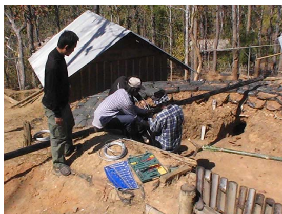
รูปที่ 134 ผู้ช่วยนักวิจัยประกอบยึดหูสายสลิง เสา กัณฑ์หลม
