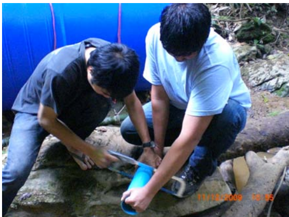
รูปที่ 97 ผู้ช่วยนักวิจัย ติดตั้งท่อส่งน้ำจากถ้ำ พักน้ำ
