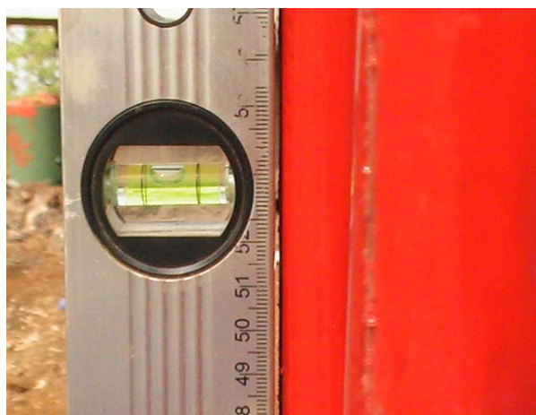
รูปที่ 166 จับระดับน้ำเพื่อให้เสาดังจากกับพื้นโลกซึ่งเป็น ขั้นตอนที่สำคัญเพราะจะมีผลต่อการหมุนของกังหันลม
