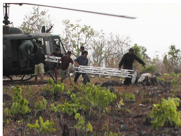
รูปที่ 160 คณะวิจัยและเจ้าหน้าที่ทหารพรานลำเลียง เสาเข็มกั้นดินลงจากเฮลิคอปเตอร์
