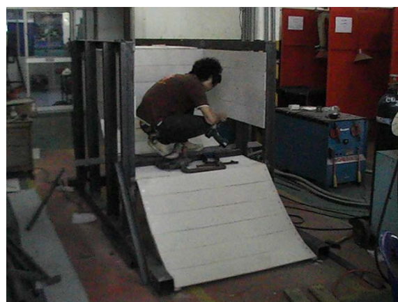
รูปที่ 194 ผู้ช่วยนักวิจัยประกอบแผ่นไม้เซอร่า บริเวณห้องรับน้ำ
