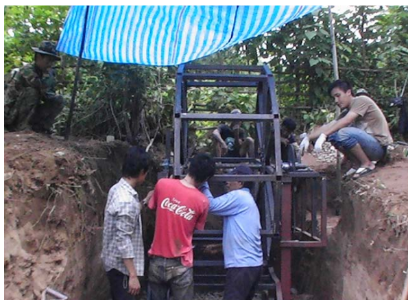
รูปที่ 216 ผู้วิจัยตรวจสอบความเรียบร้อยโครงวงล้อน้ำ
