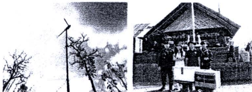
รูปที่ 23 กังหันลม ขนาด 200 W 24 V.DC ความสูงเสา กังหัน 12 เมตร ติดตั้งเรียบร้อย นักวิจัยได้ทำพิธีมอบ ให้กับ ทหารพรานฐาน BP 14
