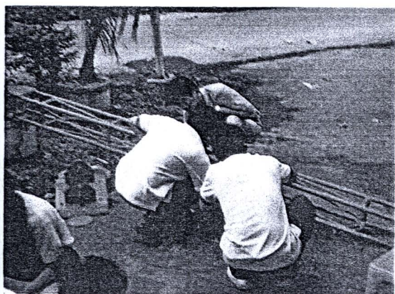
รูปที่ 143 ผู้ช่วยนักวิจัยทาสีเสากังหันลม ทั้งสอง ชุดที่จะเตรียมไปติดตั้ง
