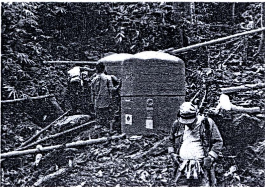
รูปที่ 95 ดำเนินการติดตั้งตำแหน่งถังพักน้ำ ไว้ด้านข้างริมห้วยเพื่อให้องค์ก้นน้ำไว้
