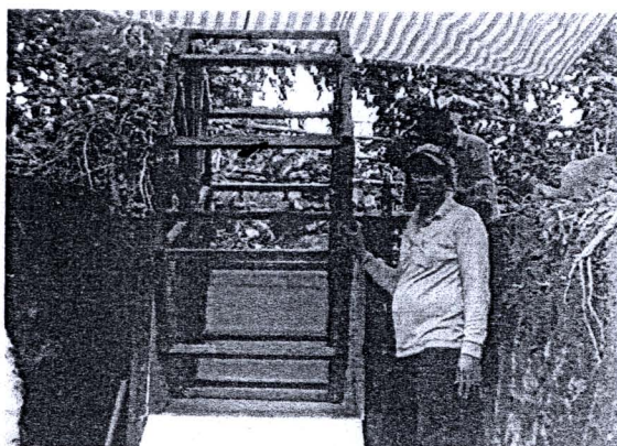
รูปที่ 218 ประกอบแผ่นไม้ห่อราติดกับโครงฐานวงล้อน้ำ
