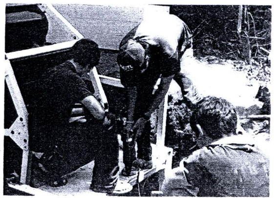
รูปที่ 222 ติดตั้งไม้เชอร์ว้าเพื่อรองรับ Water intake
