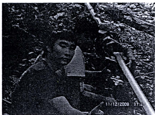
รูปที่ 99 ผู้ช่วยนักวิจัย คัดต้งท่อส่งน้ำจากถัง พักน้ำ ผ่านผาหินที่ลาดชัน
