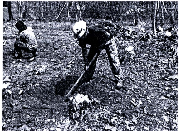
รูปที่ 152 เจ้าหน้าที่หน่วยทหารพราน BP 16 ช่วยกันขุดหลุมทำฐานยึดเสาถังหันลม
