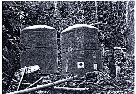
รูปที่ 96 ติดตั้งท่อส่งน้ำจากถังพักน้ำ วาล์ว ปิดเปิด และวาล์วไล่อากาศภายในท่อ
