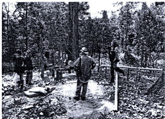
รูปที่ 103 ติดตั้งระบบท่อเข้ากังหันน้ำ
