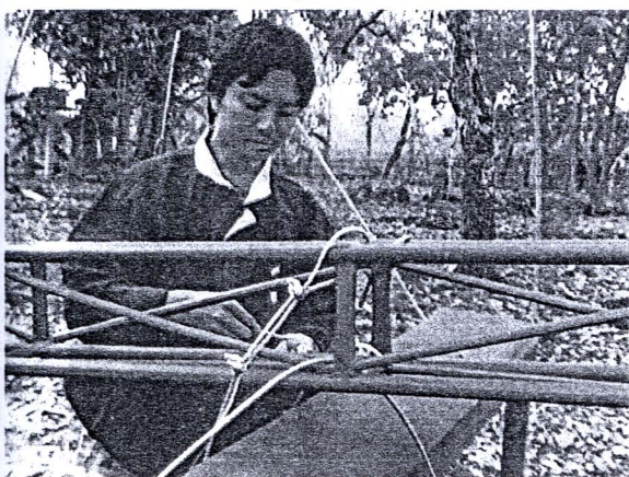
รูปที่ 161 ผู้ช่วยนักวิจัย ประกอบเสาทั้งหั่นลม และ เตรียมติดตั้งยึดเสา
