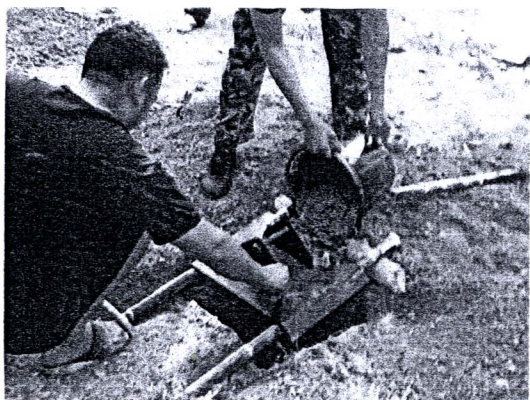
รูปที่ 131 เทปูนยึดฐานเสา กั้งหันลม
