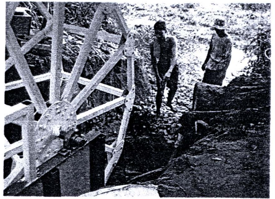
รูปที่ 220 ทาสีโครงวงล้อน้ำด้วยสีEpoxy Top Coat
