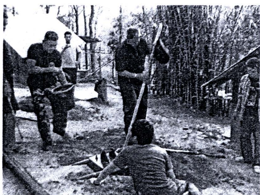
รูปที่ 132 นักวิจัยปรับระดับฐานกั้งหันลมหลังจาก เทปูนยึดฐาน
