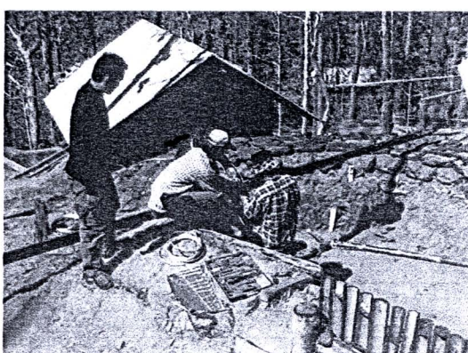
รูปที่ 134 ผู้ช่วยนักวิจัยประกอบยึดหูสายสลิง เสา กั้งหันลม
