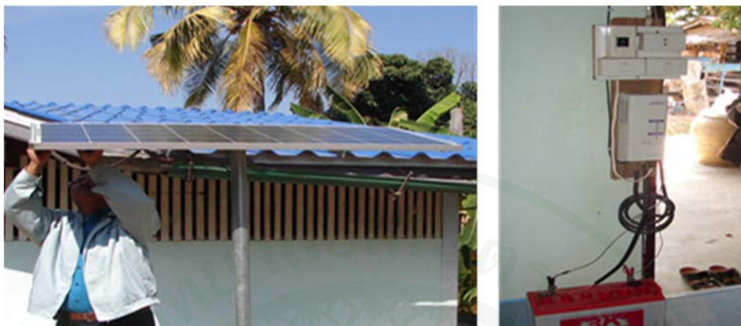
ภาพที่ 3 การติดตั้ง SHS ในโครงการเร่งรัดการขยายบริการกระแสไฟฟ้าโดยระบบผลิตกระแสไฟฟ้า ด้วยพลังงานแสงอาทิตย์
