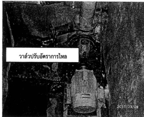
รูปที่ 3.12 ชุดควบคุมอัตราการไหล
