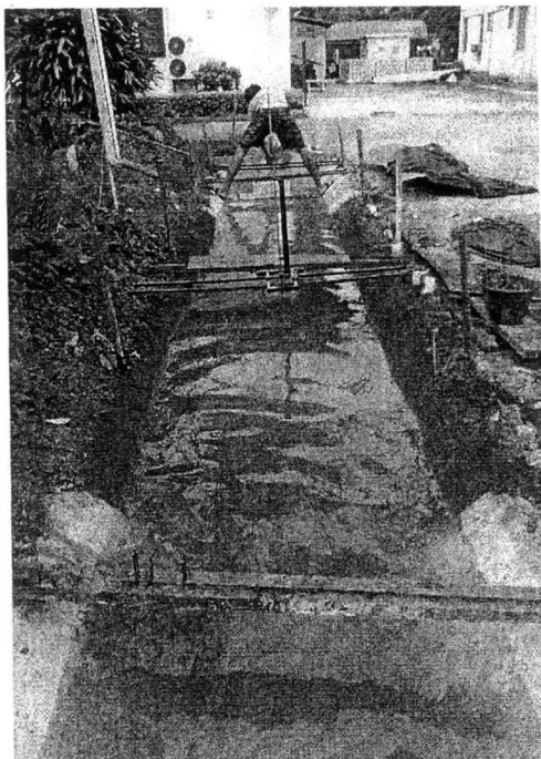
รูปที่ 3.53 การติดตั้งวัสดุตาในทางน้ำเปิด
