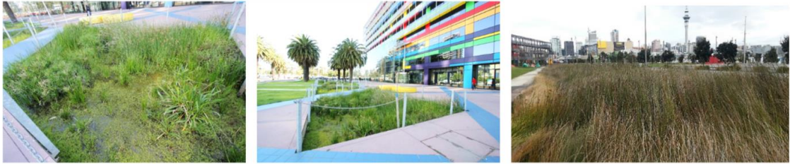
ภาพที่ 5 การจัดสร้างพื้นที่ชุ่มน้ำ เพื่อบำบัดน้ำไหลบ่าโดยพืชพื้นเมือง ก่อนปล่อยลงสู่แหล่งน้ำธรรมชาติ สถานที่: Docklands, Melbourne, Australia (ซ้าย-กลาง) Viaduct Basin, Auckland, New Zealand (ขวา) ภาพ: ผู้วิจัย
