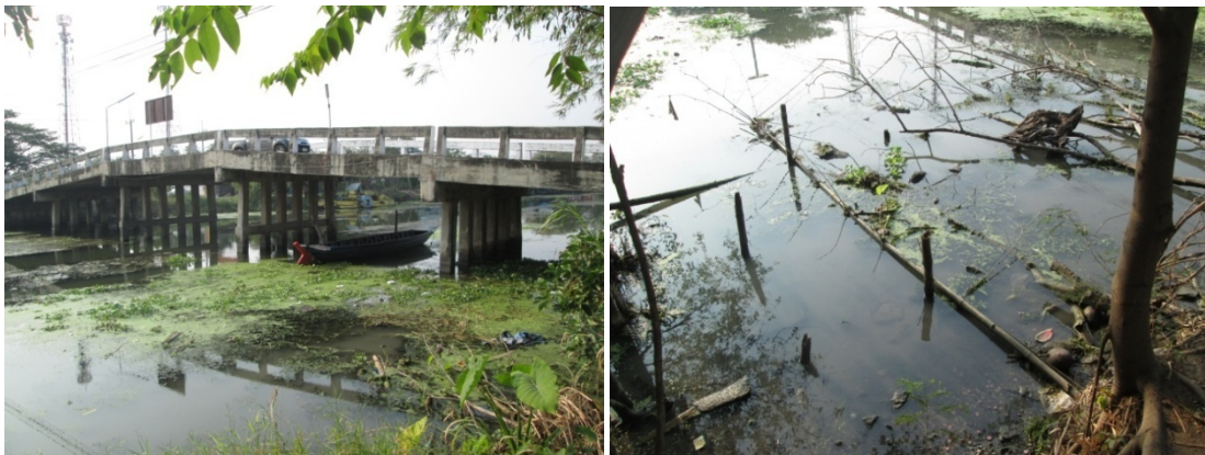
ภาพที่ 6 การสร้างสะพานที่มีเสาตอม่อ และเศษไม้ติด
