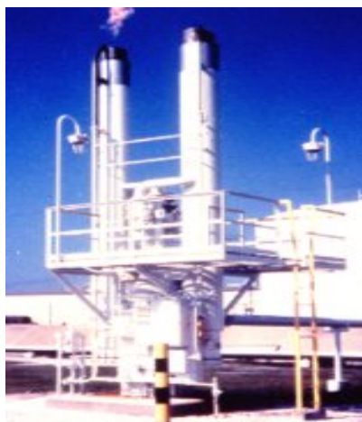
ภาพที่ 8 หน่วยควบคุมอุณหภูมิของการเกิดไอน้ำมันจากเปลวเพลิง
