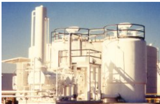
ภาพที่ 5 ระบบดูดซับไอน้ำมันโดยใช้ถ่านกัมมันต์
