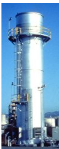
ภาพที่ 9 หน่วยควบคุมอุณหภูมิการเกิดไอระเหยน้ำมันจากเปลวเพลิงแบบปิด
