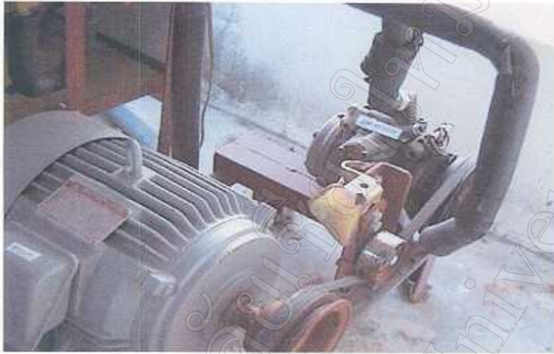
รูป 3.8 คอมเพรสเซอร์ของระบบปั๊มความร้อน
