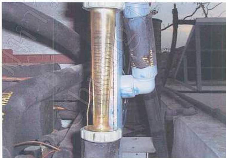
รูป 3.12 เกจวัดอัตราการไหลของน้ำ
