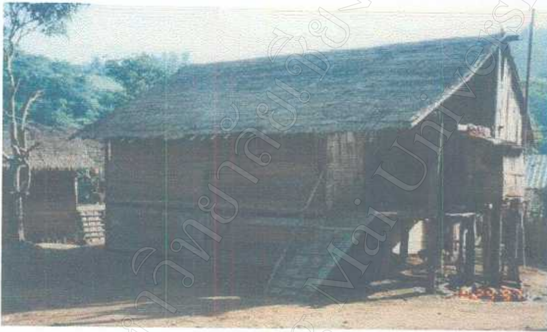
ลักษณะที่ 2 การปลูกเรือนแบบฝาเรือนทำด้วยไม้แผ่น หลังคามุงด้วยไพลา - ในหมู่บ้านมีจำนวน 10 หลังคาเรือน
