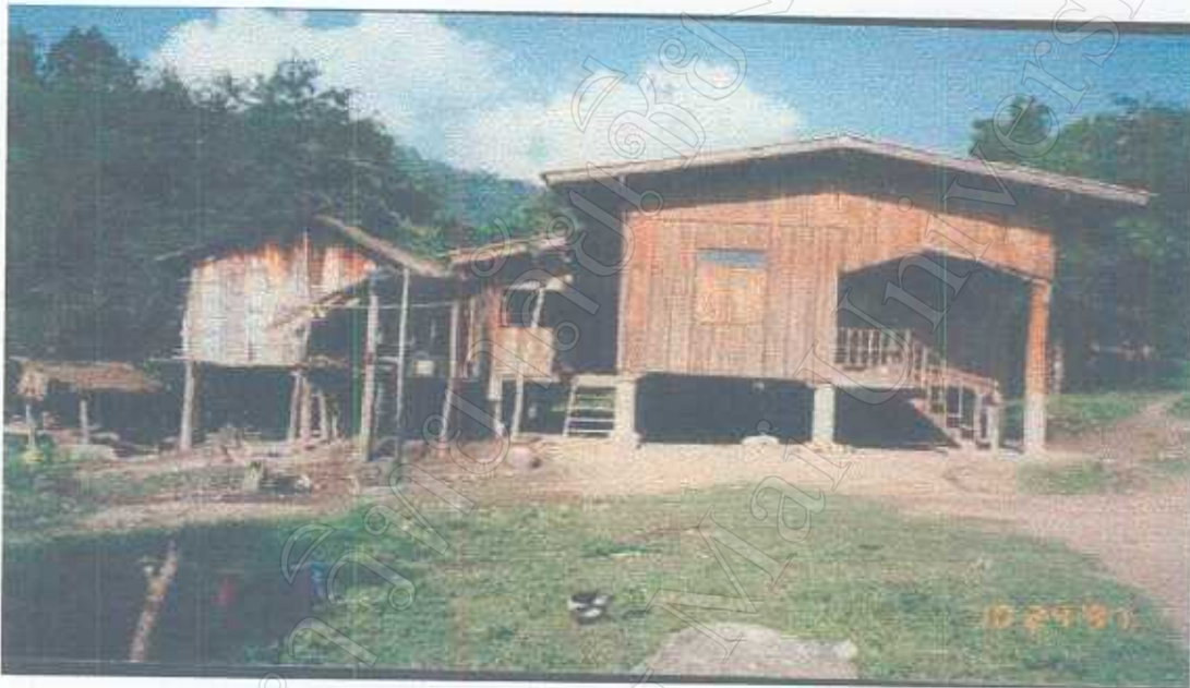
ลักษณะที่ 3 การปลูกเรือนแบบฝาเรือนทำด้วยไม้แผ่น หลังคามุงด้วยกระเบื้องและสังกะสี - ในหมู่บ้านมีจำนวน 4 หลังคาเรือน
