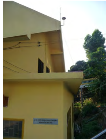
รูปที่ 2.8 เสาอากาศ เสาหล่อฟ้าและ แผ่นป้ายแสดงชื่อสถานีจีพีเอสต่อ เนื่อง SPRB และหน่วยงาน ผู้ดำเนินการและสนับสนุน
