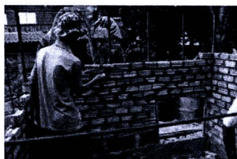
การก่ออิฐภายใน
