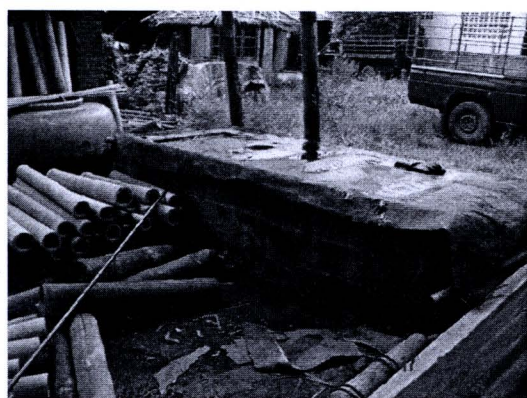
การแช่น้ำในบ่อคอนกรีต
