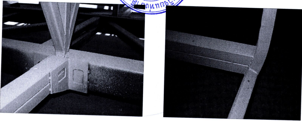
ภาพที่ 3.3 แสดงลักษณะการเชื่อมต่อโครงสร้างด้านข้างกับแชสซี
