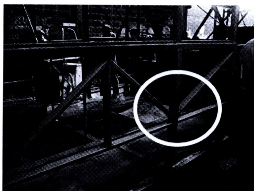
ภาพที่ 3.7 แสดงการต่อโครงสร้างด้านข้างกับชิ้นส่วนโครงสร้างแนวตั้งและแนวนอนตามลำดับ
