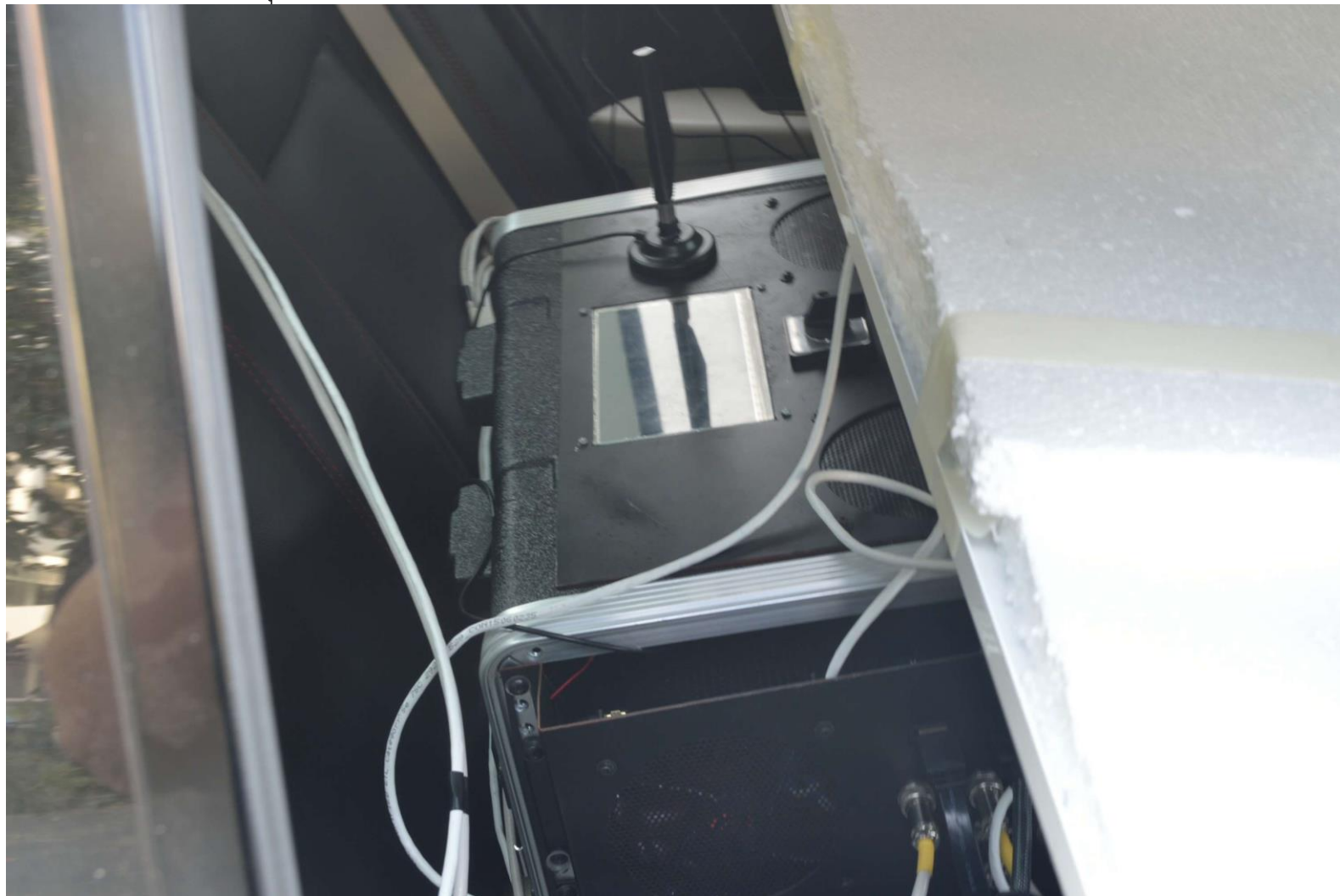
ภาพที่ 17 ภาพจำลองการติดตั้งการติดตั้งอุปกรณ์เบาหหลังรถยนต์
