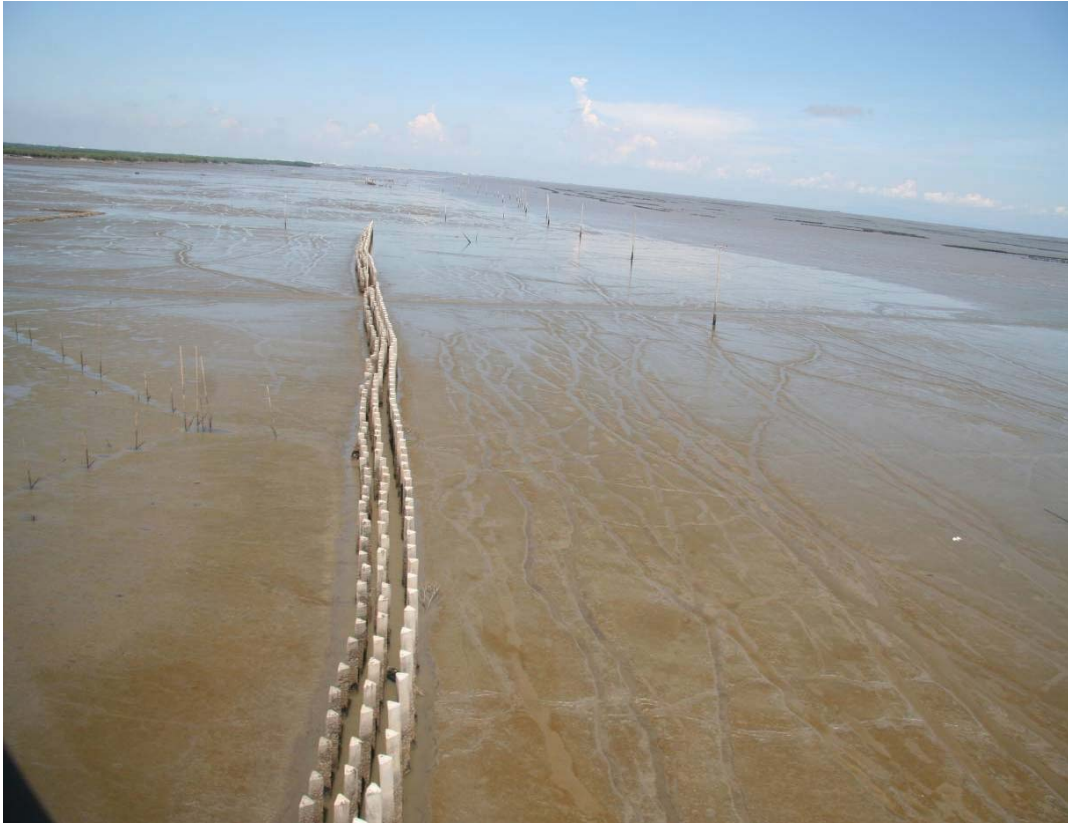
รูปที่ 5.1 แสดงการกัดเซาะระดับพื้นท้องน้ำบริเวณที่มีการติดตั้งโครงสร้างเสาสามเหลี่ยม “เชื่อมสลายกำลังคลื่น” จากคลื่นม้วนตัวปะทะโครงสร้าง (Scouring)
