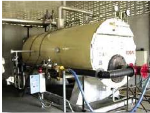
รูปที่ 3-20 การใช้ก๊าซชีวภาพเป็นเชื้อเพลิงสำหรับหม้อไอน้ำ
