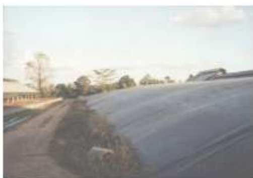
รูปที่ 3-15 ขบวนการย่อยสลายสารอินทรีย์ในสภาวะไร้อากาศแบบระบบบ่อปิด
