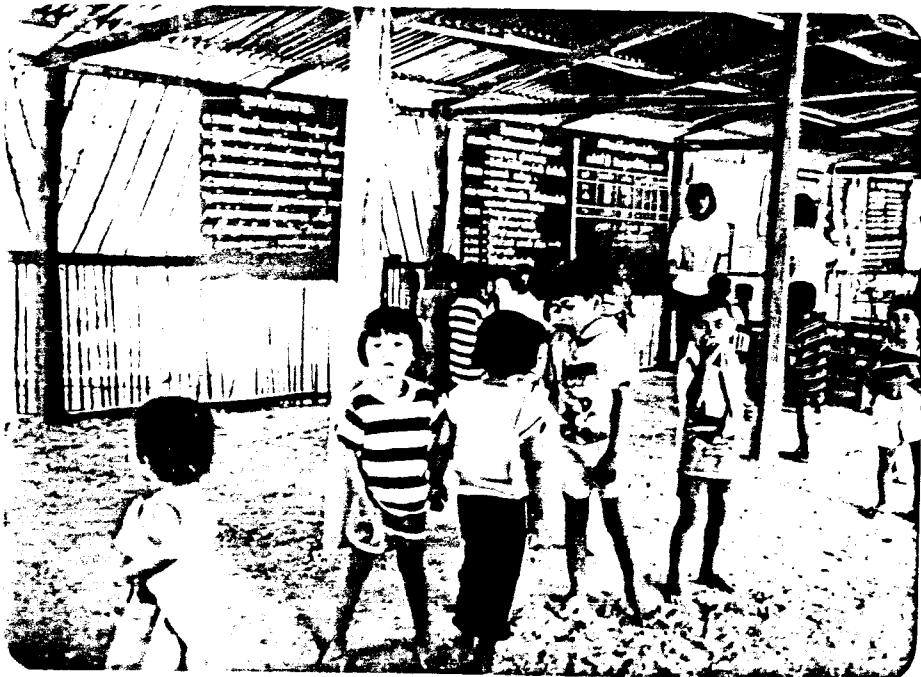
ภาพที่ 6 สภาพภายในของอาคารชั่วคราว
