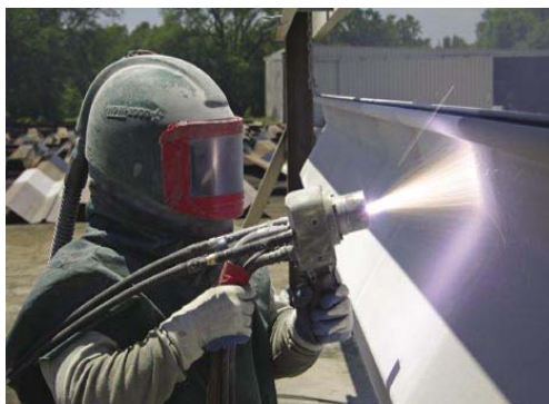
รูปที่ 6.31 การพ่นเคลือบโลหะ “The thermal spraying”
