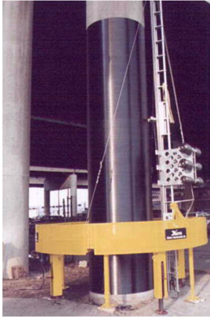
รูปที่ 6.35 ลักษณะการดำเนินการหุ้มผิวของเสาตอม่อของอาคารขนาดใหญ่
