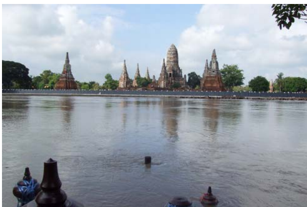
รูปที่ 5.1 ทศนียภาพอาคารโบราณสถานเมื่อทำการก่อกั้นกั้นน้ำท่วมแล้ว
