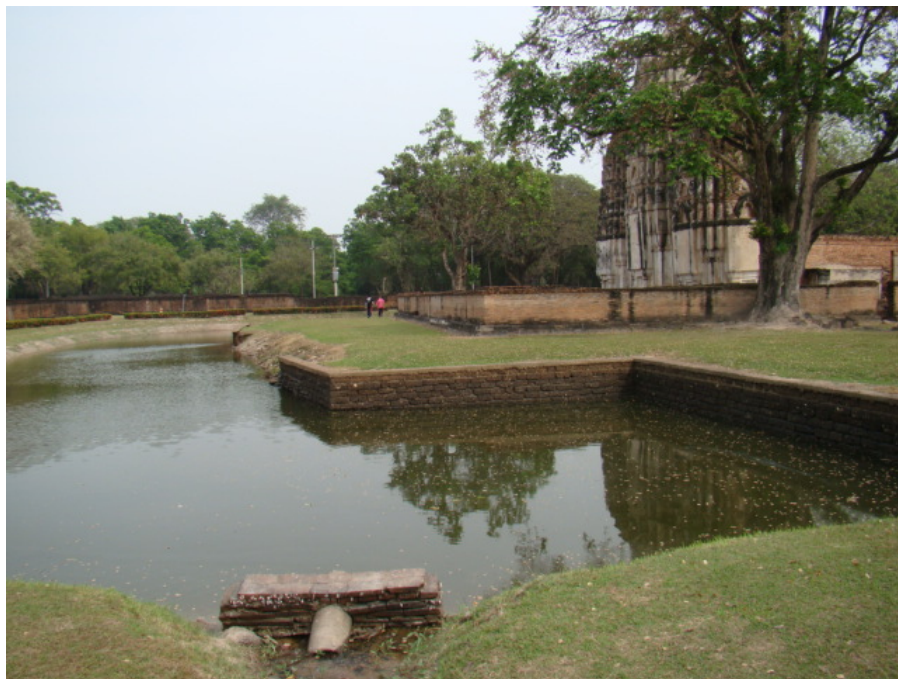
รูปที่ 3.12 ท่อจ่ายและควบคุมน้ำในสระอุทยานฯสุโขทัย (อุปกรณ์ชลประทานและกันน้ำท่วม)
