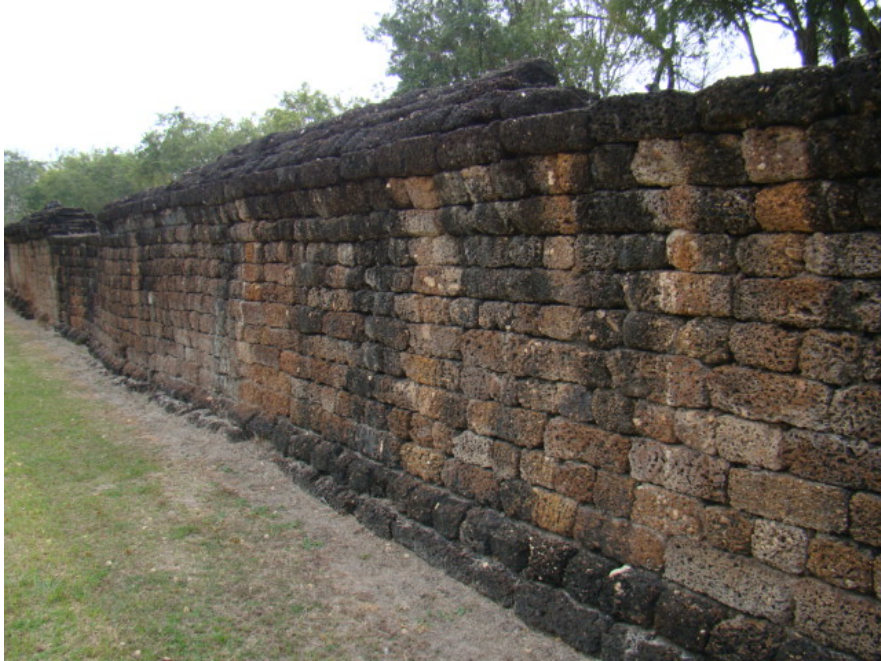
รูปที่ 3.13 กำแพงกั้นน้ำทำด้วยศิลาแรงของวัดศรีสวาย ในอุทยานฯสุโขทัย
