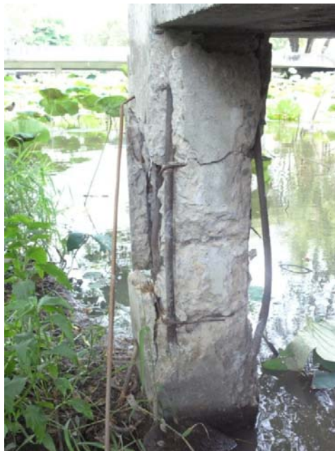
รูปที่ 2.4 สภาวะภายนอกที่ตรวจพบ 4 หลังจากการใช้งานมาแล้ว 45 ปี
