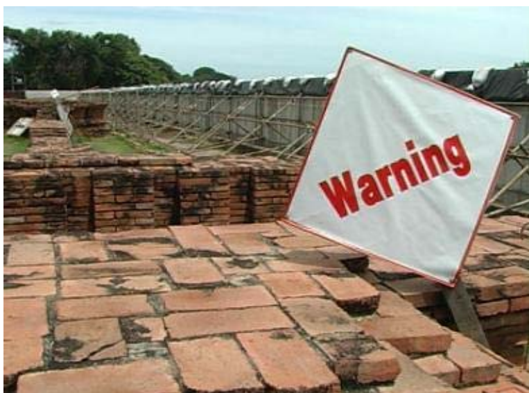
รูปที่ 2.20 แนวหลังพนังกั้นน้ำ
