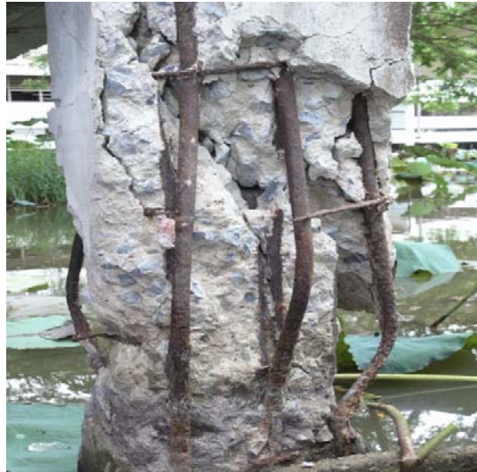
รูปที่ 2.3 สภาวะภายนอกที่ตรวจพบ 3 หลังจากการใช้งานมาแล้ว 45 ปี
