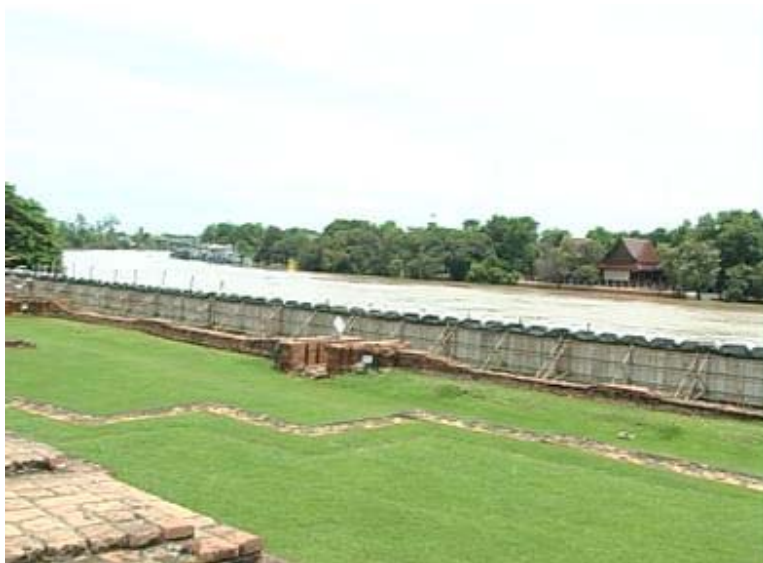
รูปที่ 2.19 การทำงานของพนังกั้นน้ำเมื่อระดับน้ำขึ้นสูง
