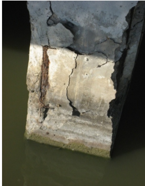
รูปที่ 2.1 สภาวะภายนอกที่ตรวจพบ 1 หลังจากการใช้งานมาแล้ว 45 ปี (อาคารในสถาบันเทคโนโลยีพระจอมเกล้าเจ้าคุณทหารลาดกระบัง)
