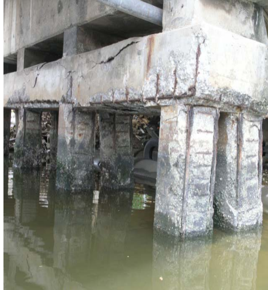
รูปที่ 2.9 สภาวะภายนอกที่ตรวจพบ 1 สะพานศูนย์ฝึกพาณิชย์นาวี
