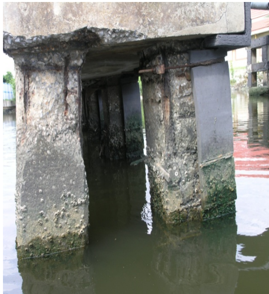
รูปที่ 2.10 สภาวะภายนอกที่ตรวจพบ 2 สะพานศูนย์ฝึกพาณิชย์นาวี
