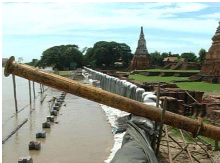
รูปที่ 2.18 การก่อสร้างกำแพงกันดินริมคลองในเบื้องต้น
