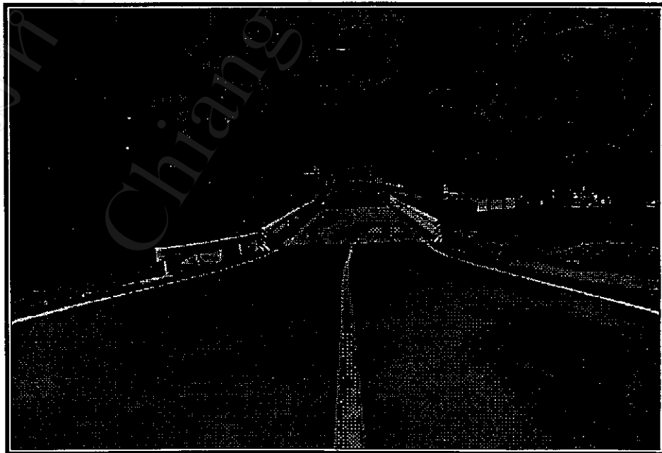
รูป 3.7 แสดงบริเวณที่ใกล้กับแนวสะพานที่ควรหลีกเลี่ยงในการเก็บข้อมูลความเร็ว
