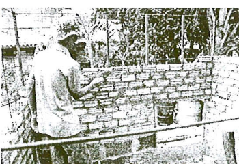
การก่ออิฐภายใน
