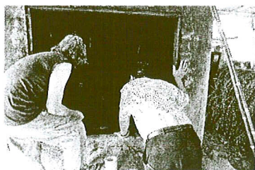
การก่อสร้าง
