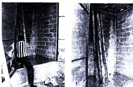
การวางไม้ไฟภายในเตา เพื่อทดลอง
