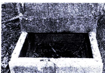
ช่องก่อเชื้อเพลิง
