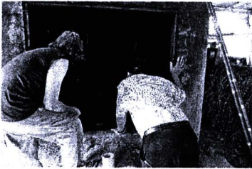
การก่อสร้าง
