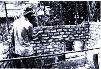
การก่ออิฐภายใน
