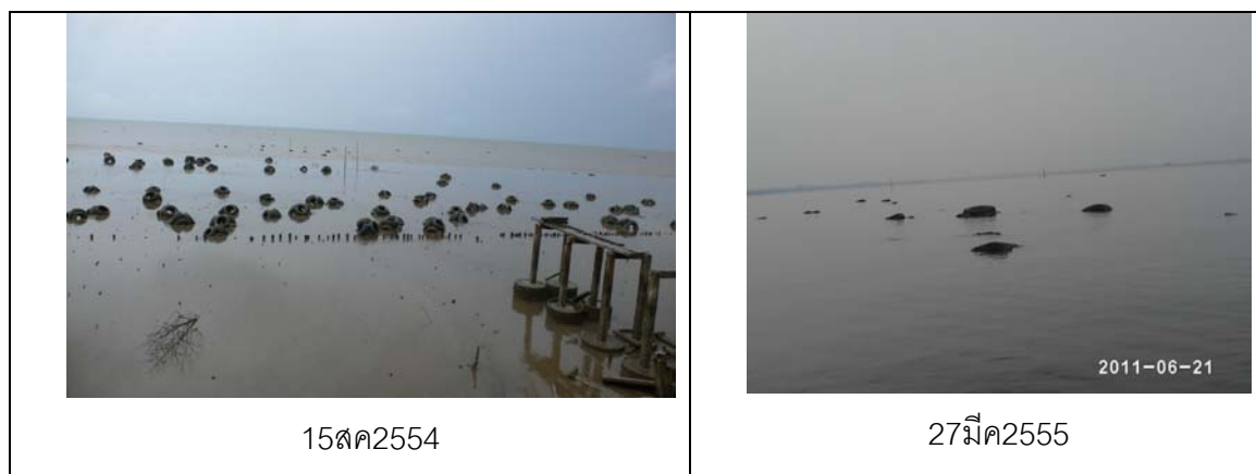
รูปที่ 54 เตาที่ยางที่จมโคลนและบางส่วนเคลื่อนที่ออกจากจุดวางมาก
