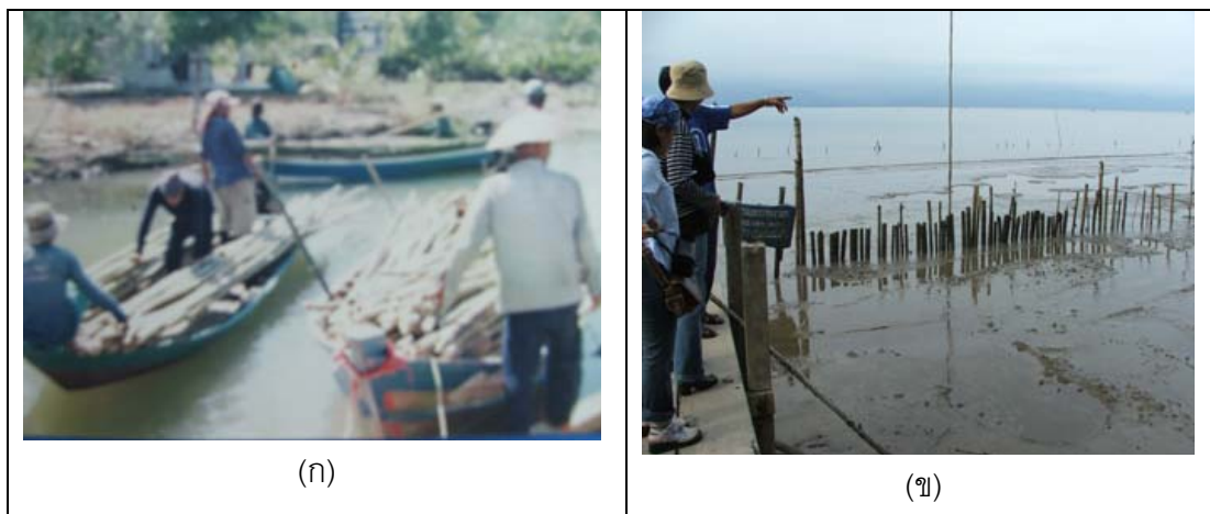
รูปที่ 2 การปักแนวเขตด้วยไม้ไผ่เพื่อทดลองลดการกัดเซาะชายฝั่งและฟื้นฟูทรัพยากรธรรมชาติชายฝั่ง พ.ศ.2546 (ก) เตรียมไม้ไผ่จากภายในพื้นที่ (ข) บริเวณที่ทำการศึกษา
