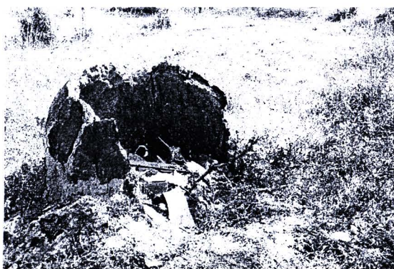
เตาเผาถ่านหลังการใช้งานโครงสร้างยังมีความแข็งแรง
