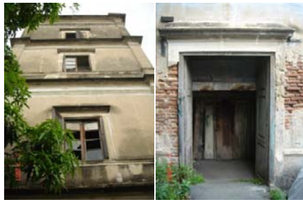
โถงบันไดอาคารประธาน (ภายนอก)
